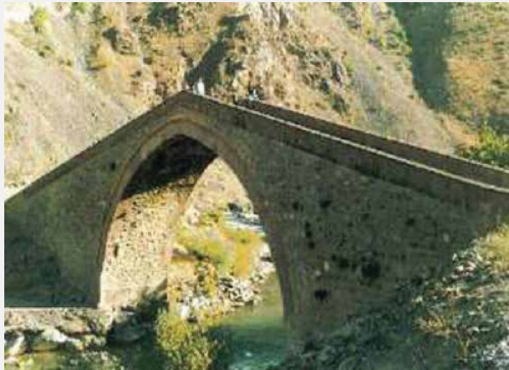
Fotoğraf 21: Çatak Köprüsü
