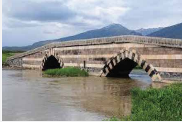
Fotoğraf 19: Bend-i Mahi Köprüsü
