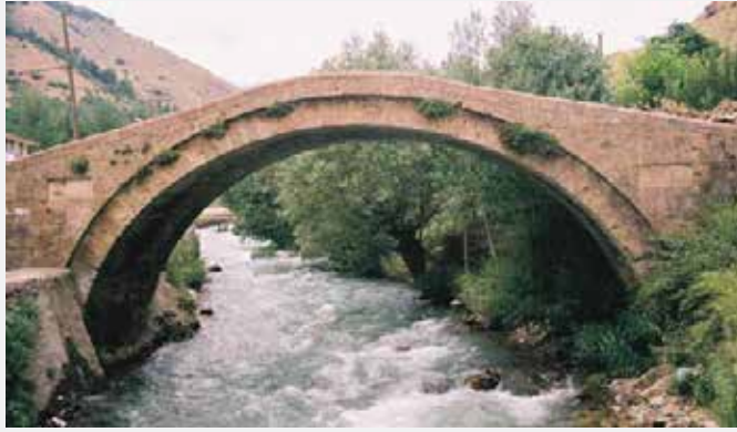
Fotoğraf 20: Çatak Köprüsü
