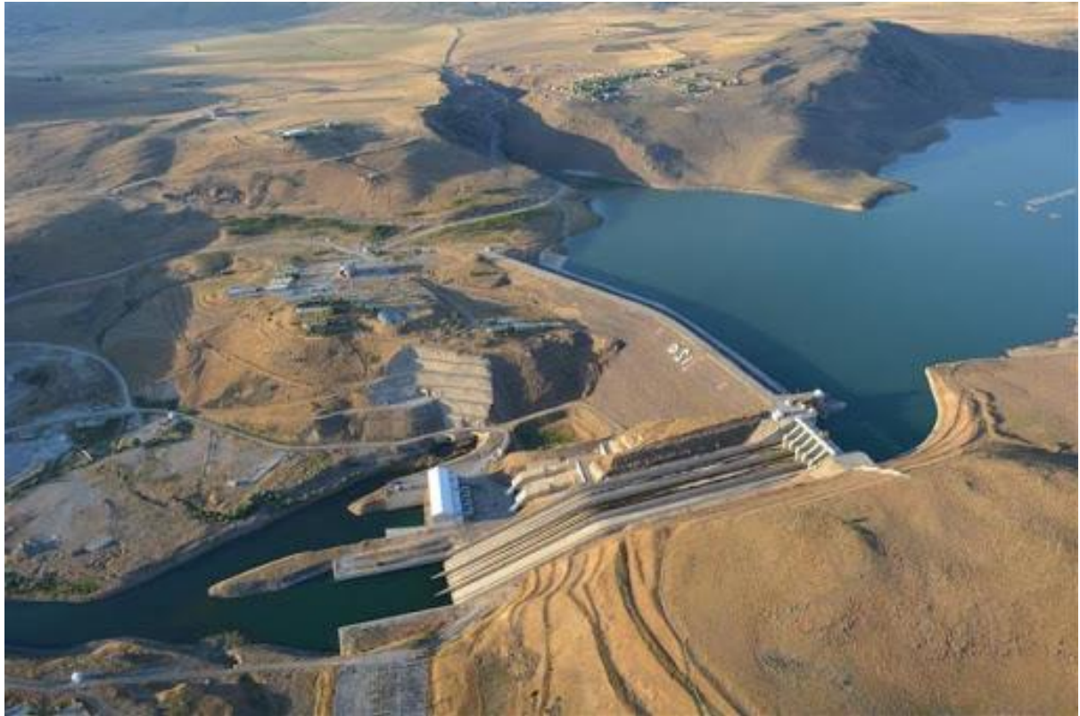
Şekil 12: Muş Alpaslan-1 Barajı ve Hidroelektrik Santrali
