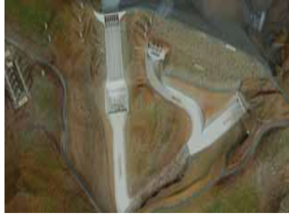
Şekil 4: Barajlı hidroelektrik santral yapım aşamaları
