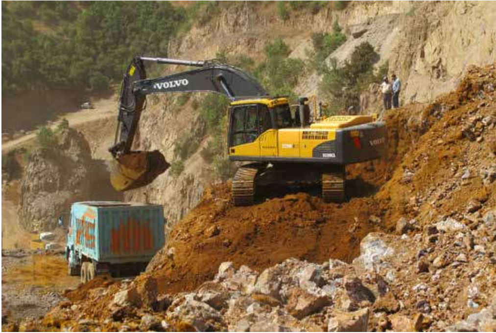
Şekil 22. Açık işletme ile yapılan üretimin görünümü.
