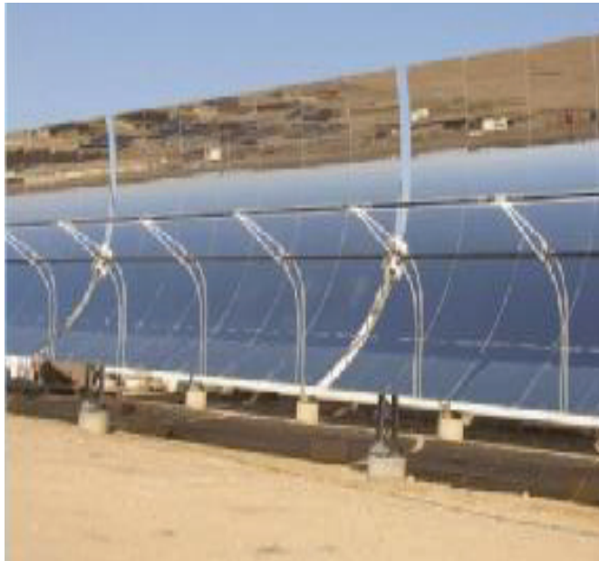
Şekil 24: Parabolik oluk aynalar ve çalışma şekli.
