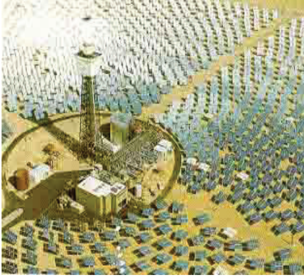
Şekil 33: Merkezi alıcılı güneş termal santrali.(Merkezi alıcı)
