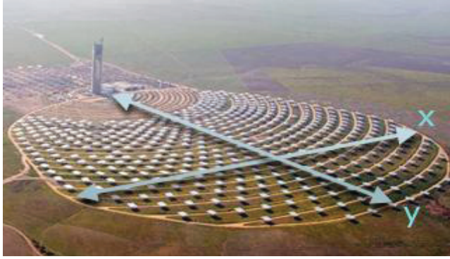
Şekil 37: 20 MW'lık merkezi alıcılı güneş termik santrali.
