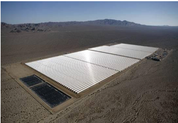
Şekil 26: 64 MW güce sahip bir parabolik oluk güneş termik santrali.
