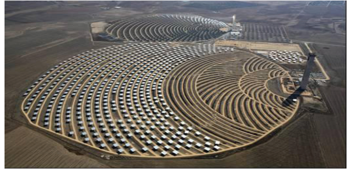
Şekil 36: Merkezi sistem alıcı ünitesi, düz aynalı yansıtıcı(heliostat) sistemler.
