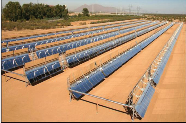
Şekil 26: 64 MW güce sahip bir parabolik oluk güneş termik santrali.
