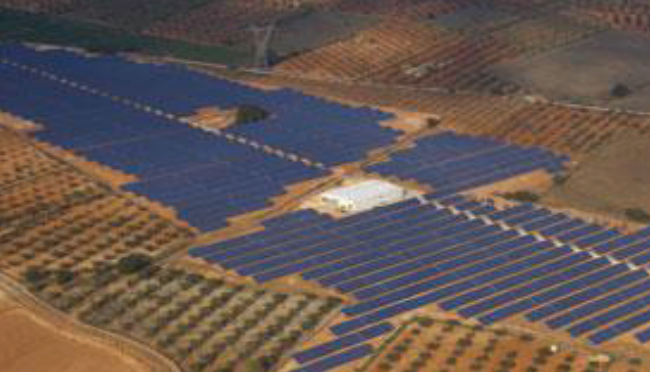
Şekil 23: Düz ve eğimsiz alana sahip bir güneş termik elektrik santrali.
