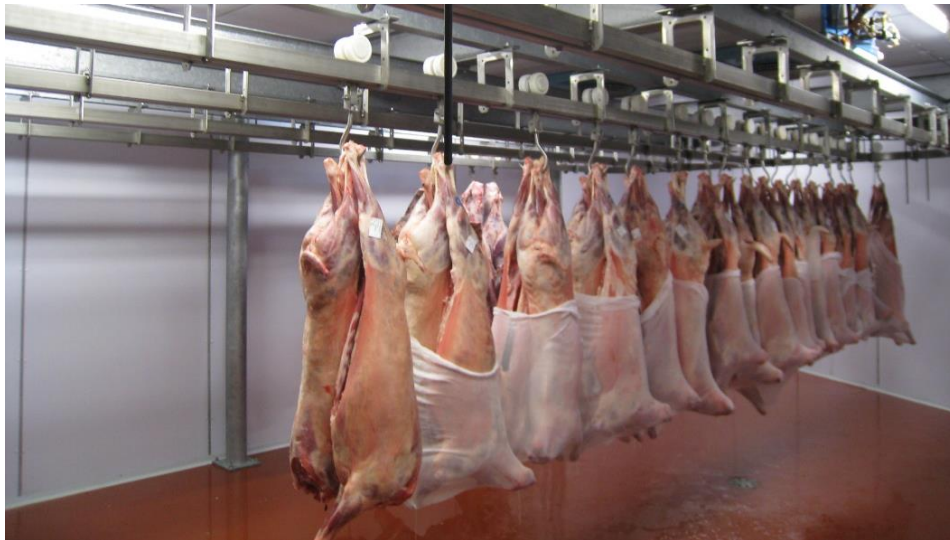
Şekil 2. Karkas halindeki etlerin soğuk hava depolarında saklanması.
