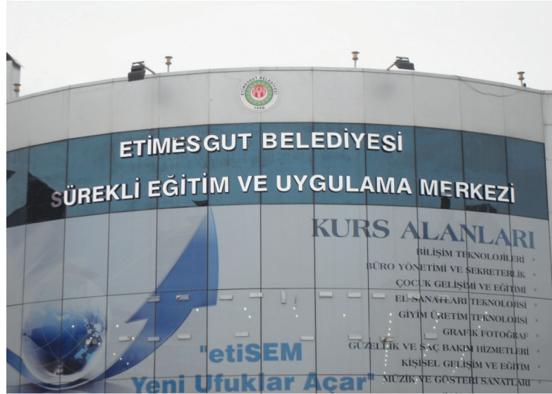
Etimesgut Belediyesi Sürekli Eğitim ve Uygulama Merkezi Ana Hizmet Binası
