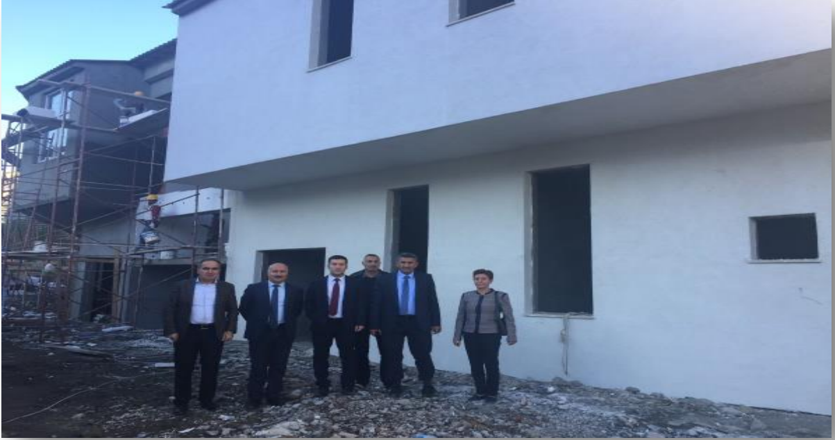
Fotoğraf 57: İŞGEM Binası Çalışmaları
